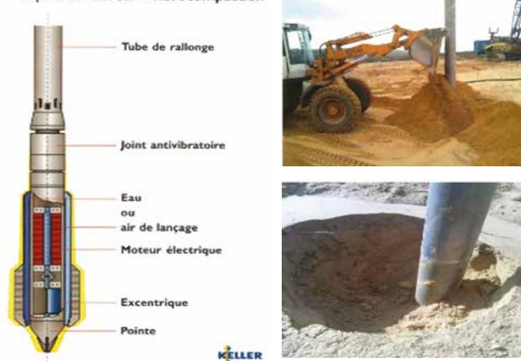
Figure 2 : vibro-compactage – mise en œuvre
